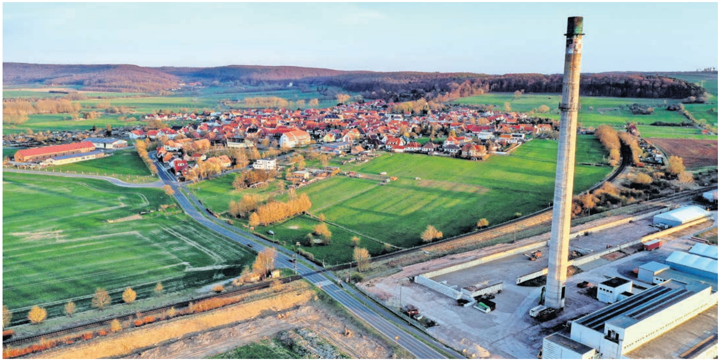
Der Schornstein am alten Heizwerk in der Südstadt von Leinefelde wird gesprengt.
