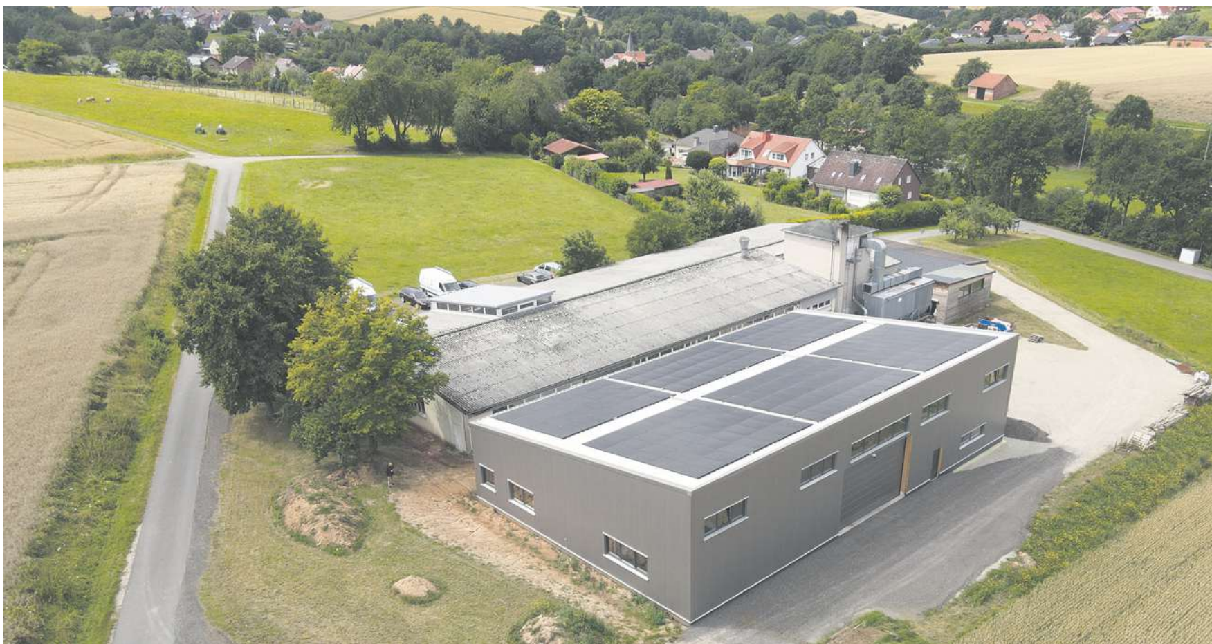
Die neue Produktionshalle der Tischlerei Paul Otto im Duderstädter Ortsteil Langenhagen.
